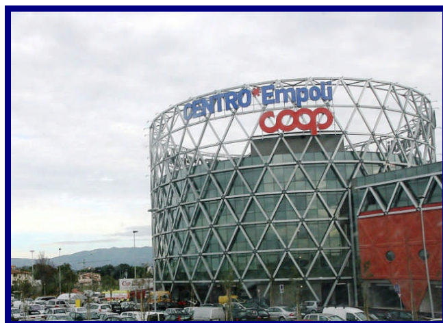
Centro commerciale COOP Empoli
