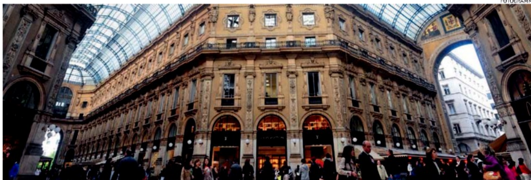
Architettura milanese. Una veduta della Galleria Vittorio Emanuele II, costruita a partire dal 1846 e uno dei simboli della città
